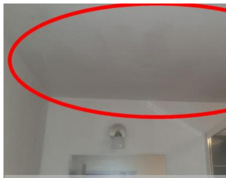
Reprise de la couverture et remise en peinture du plafond de la salle de bain
