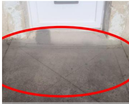
Bordure et calfeutrement refait devant la porte d'entrée
