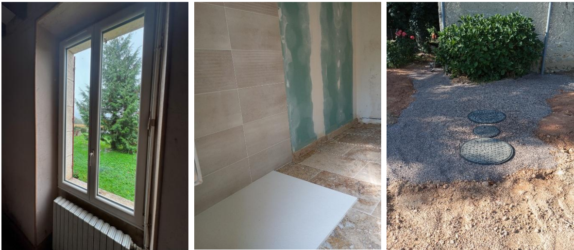
Travaux en cours
