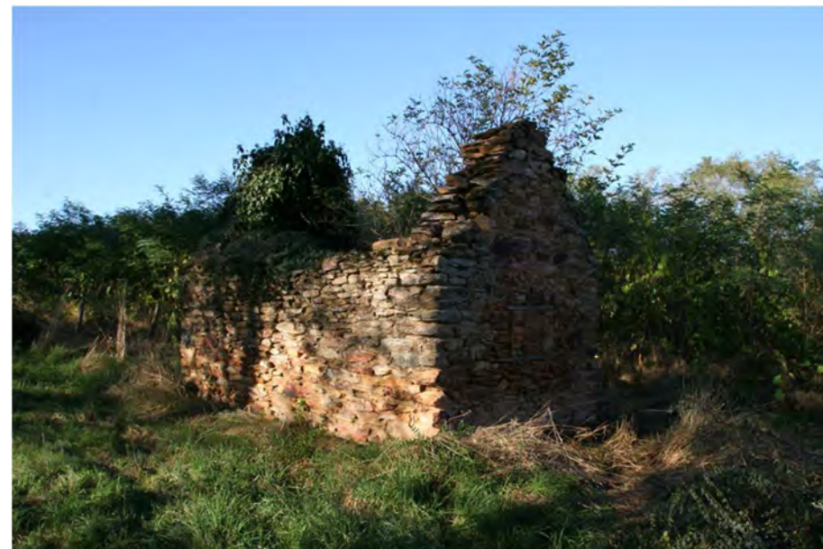
Figure 32 : Loges de vigne ruinées et friche viticole envahie par le robinier
