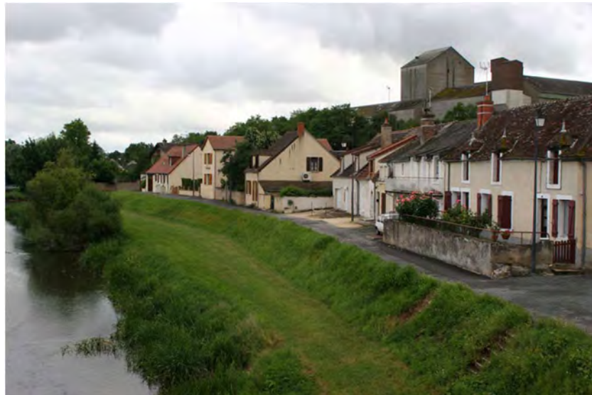
Figure 34 : Développement urbain le long du Cher à Châteauneuf-sur-Cher
